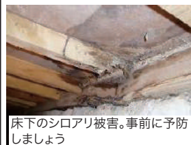
シロアリの蟻道です。見かけたら被害の可能性大!!
